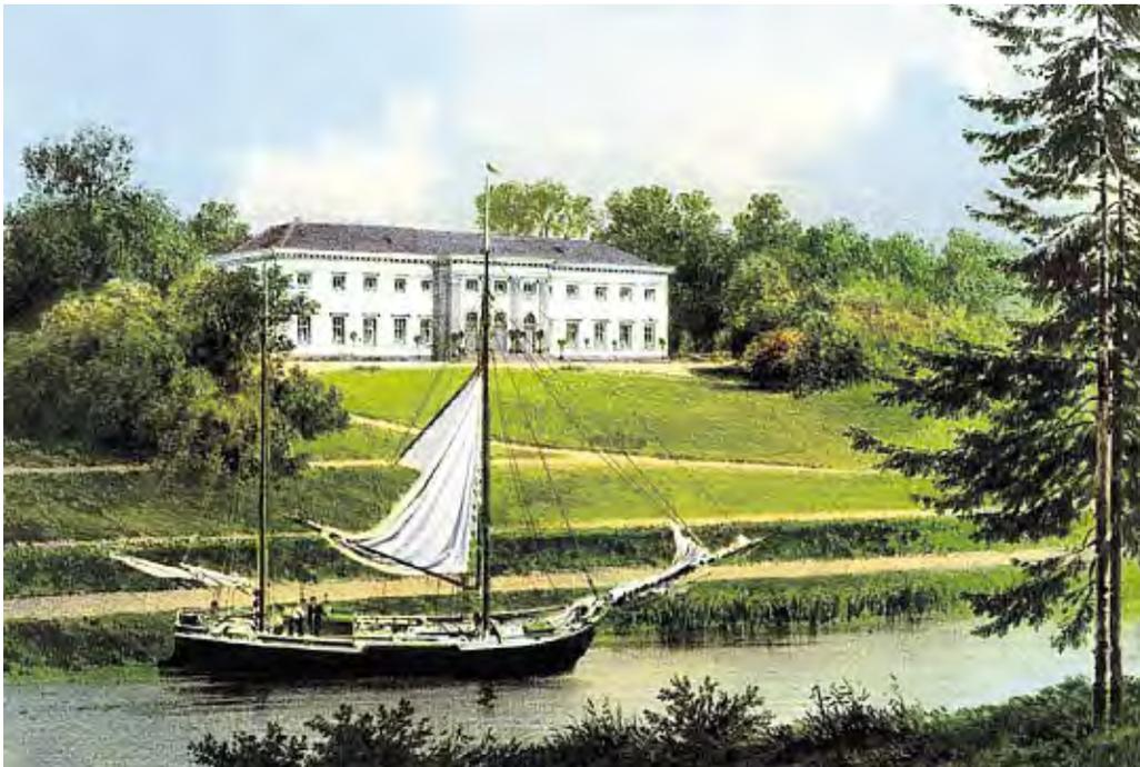
**Der Eiderkanal um 1860, hier bei Gut Knoop:** Sein Manko für modernere Schiffe waren die geringe Breite und Tiefe. Die Sohle war 18 Meter breit, die Wassertiefe lag bei 3,45 Meter. FOTO: WIKIPEDIA
