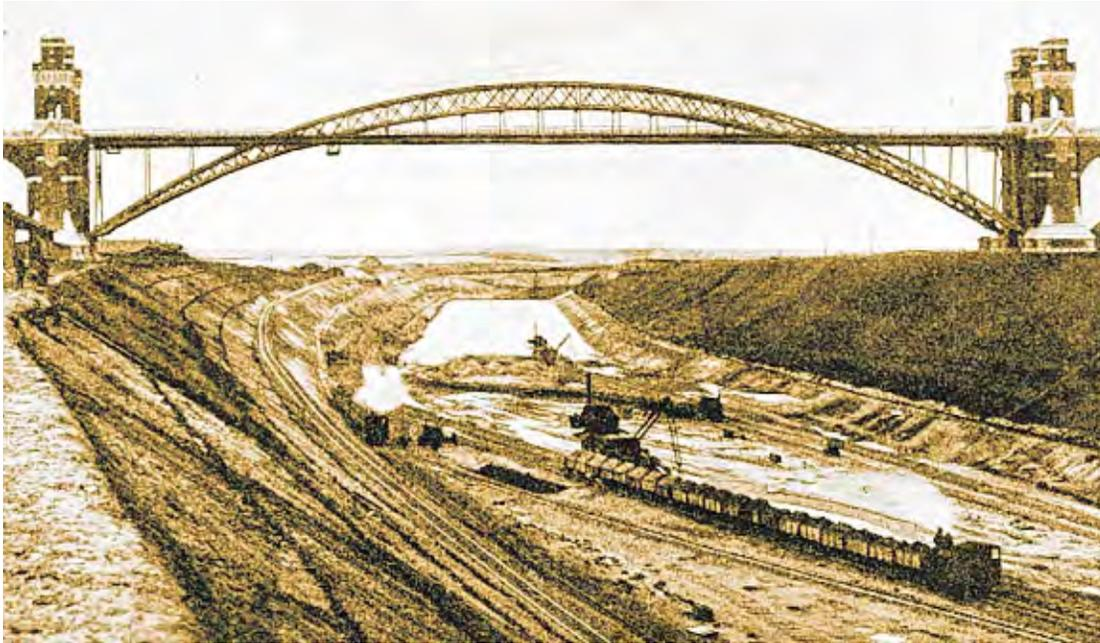
**Bau der Levensauer Hochbrücke:** Insgesamt gibt es zehn Kanalbrücken mit einer lichten Durchfahrthöhe von jeweils 42 Metern.
