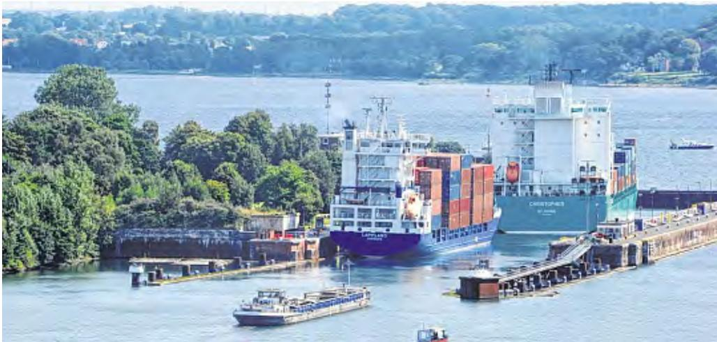
**Die Schleusenanlage in Kiel-Holtenau:** Gemeinsam mit den Schleusen in Brunsbüttel sorgt sie für einen Wasserpegel im Kanal von 20 Zentimetern unter dem Meeresspiegel (NN). Der Unterschied zum Pegel in der Kieler Förde (20 Zentimeter über dem Meeresspiegel) beträgt somit 40 Zentimeter. FOTO: STAUDT
