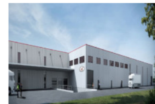
2016 Erweiterung des Logistikzentrums
